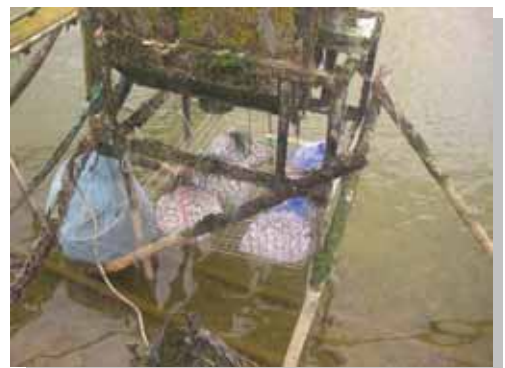
養鰻池での施工例
